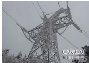
電塔、電線被冰雪破壞
